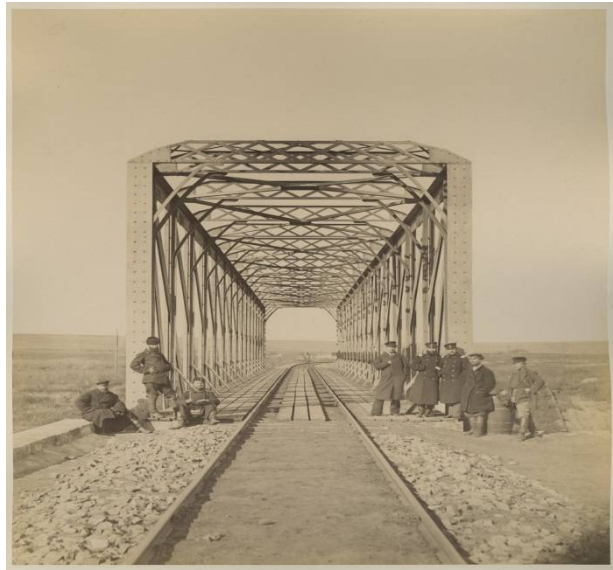
Міст на р. Казенний Торець поблизу станції Краматорська
