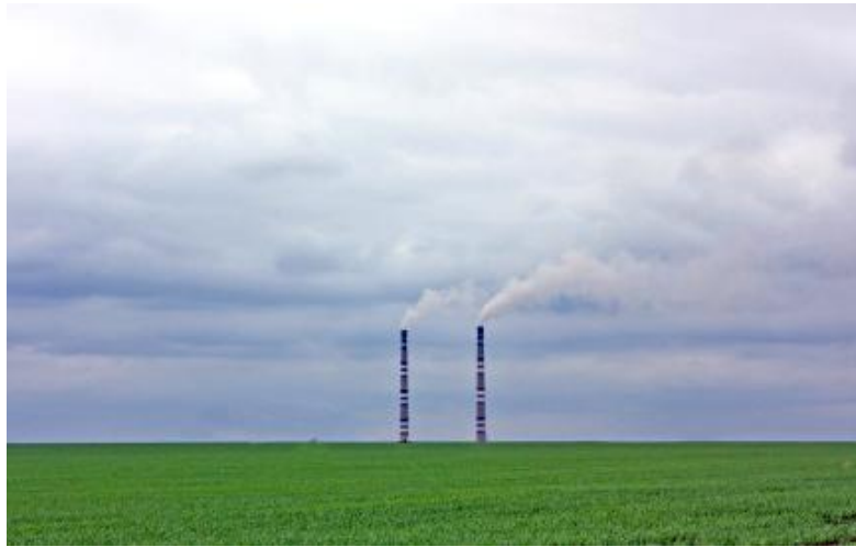
Св. 64. Курахівська теплоелектростанція
